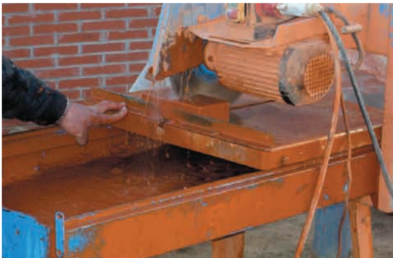
Realización de corte de un adoquín cerámico con mesa cortadora
