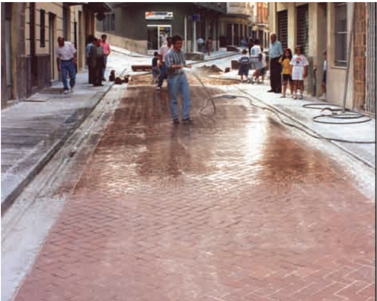
Regado del adoquinado
