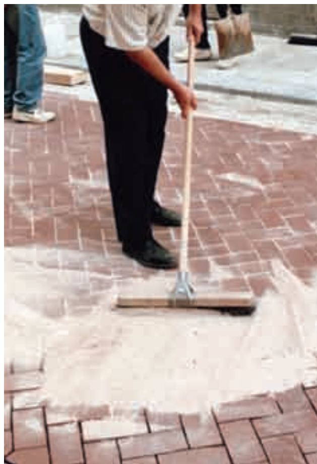
Relleno de juntas mediante barrido
