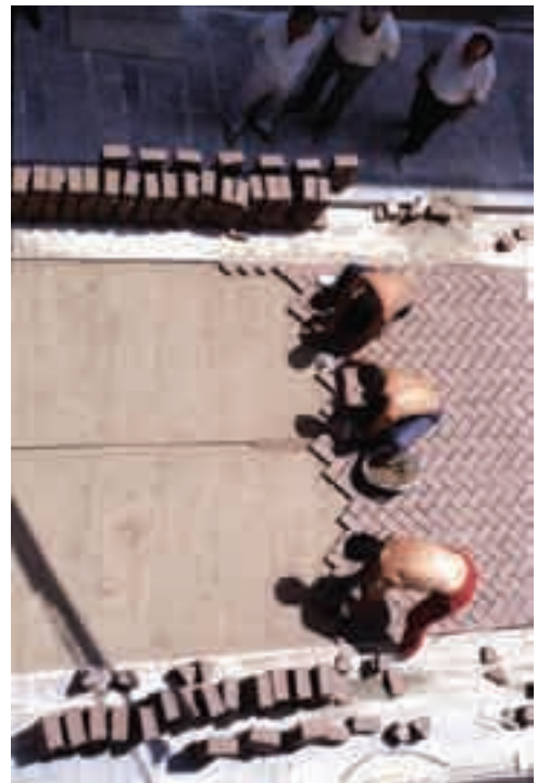
Alineación de adoquines golpeando con maceta
