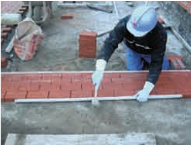
Alineación de adoquines golpeando con maceta
