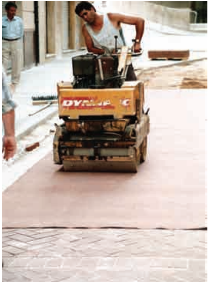
Compactación del adoquinado
