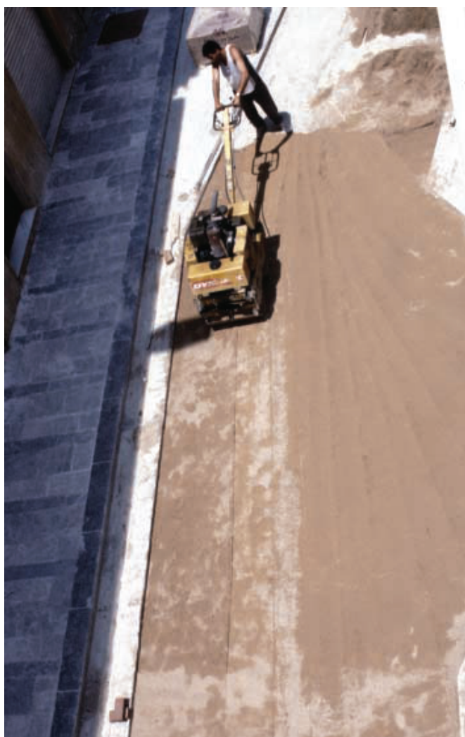
Compactación de la capa de arena
